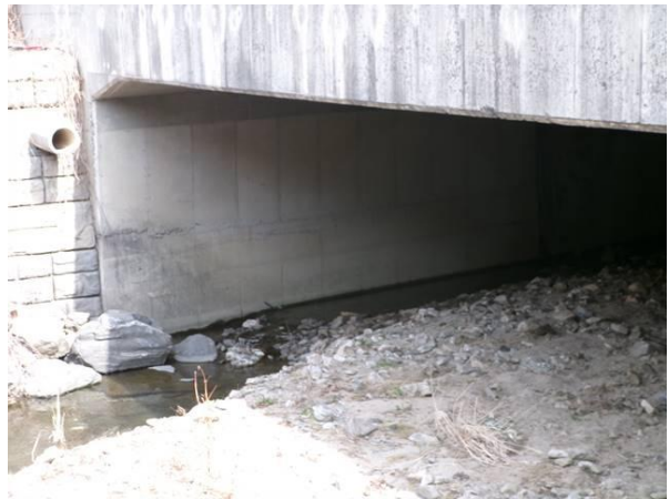
송문3교 하부구조 전경
