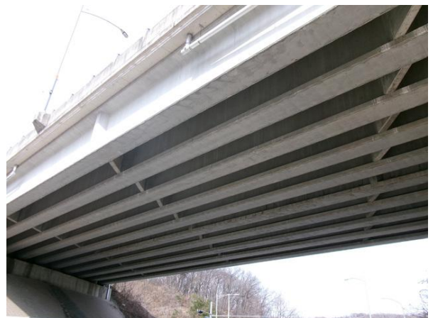
당목교 상부구조 전경
