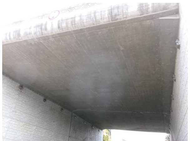
영릉1교 상부구조 전경
