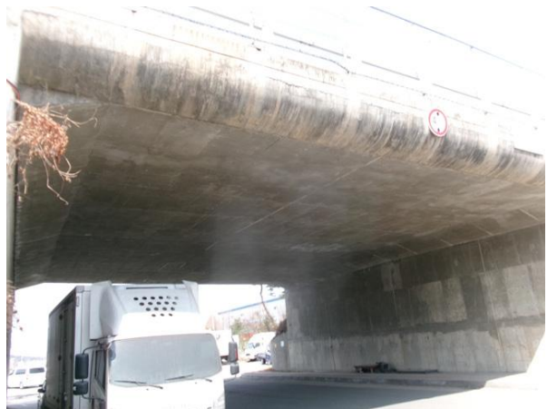
신원육교 상부구조 전경
