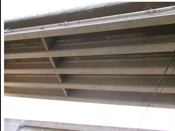
궁촌1교(상) 상부구조 전경
