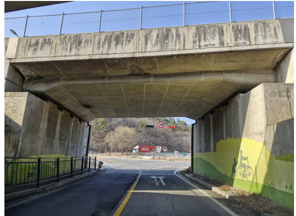
오천교차1교 상부구조 전경
