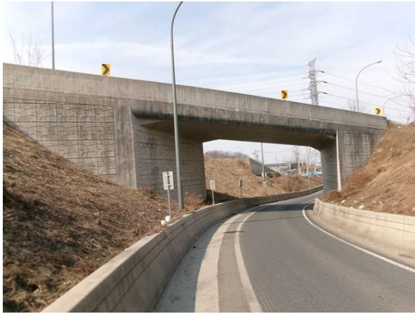
대촌IC RAMP-D교 측면전경
