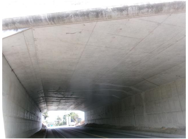
청안1교 상부구조 전경
