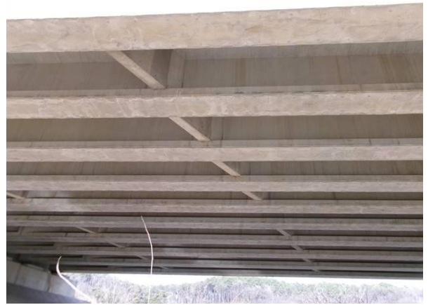
신기교 상부구조 전경
