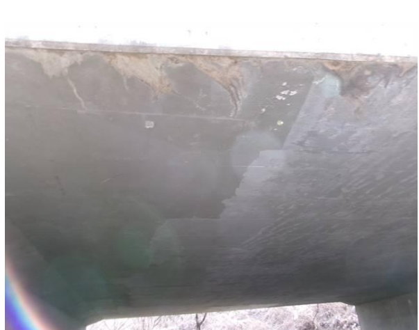
양지2교 상부구조 전경
