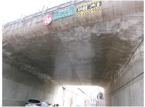
백록육교 상부구조 전경
