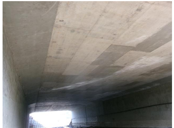
덕평1교 상부구조 전경
