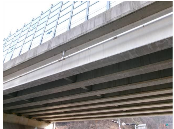
역동교 상부구조 전경
