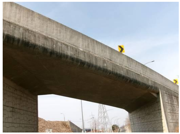
대촌IC RAMP-D교 상부구조 전경
